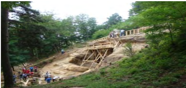
La Biserica din groță în apropierea Schitului Nașterea Maicii Domnului din Șinca Veche lucrări de restaurare și amenajare sunt în toi
